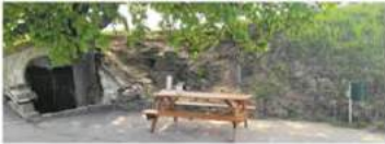
Hier bei der Radebrast in der Obernalber Kellergasse wird mit regionalen Steinen eine Trockensteinmauer in Terrassenbauweise errichtet. Fotos: Pinggera
